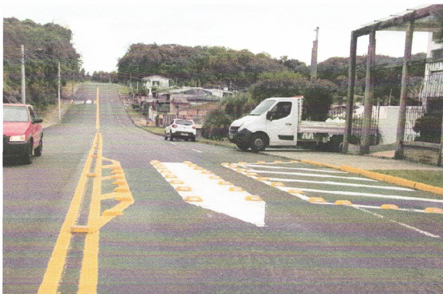
Foto 2 – Sinalização tipo lápis instalada em Caxias do Sul/RS
