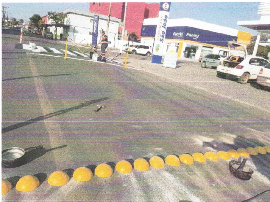
Foto 1 – Calotas refletoras instaladas em Camaquã/RS
