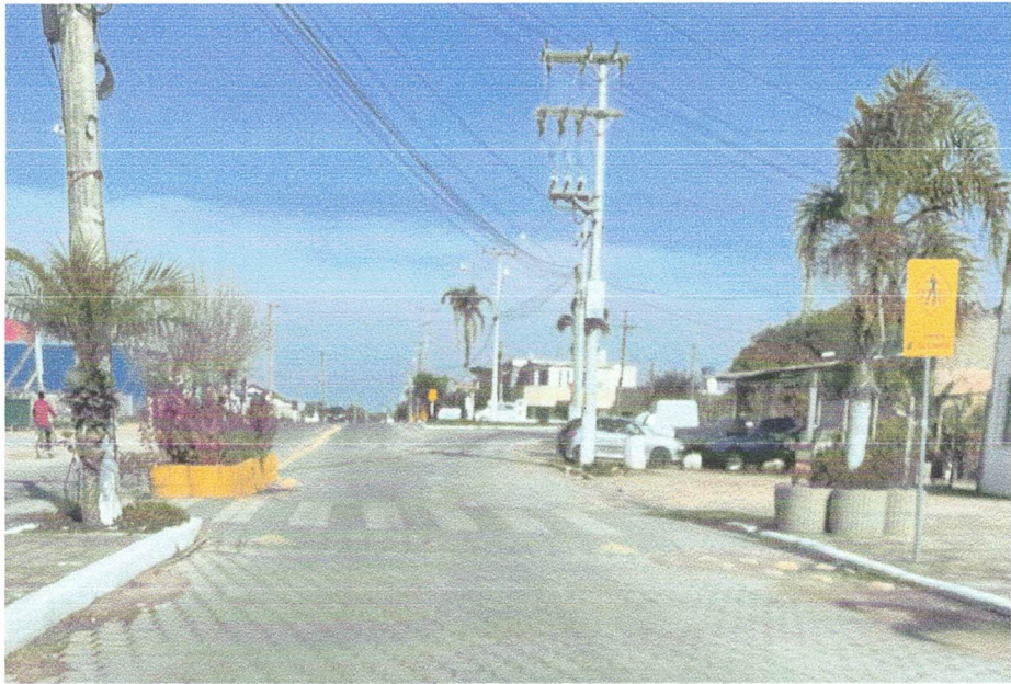
Foto 3 – Redutor tipo lombada instalada em Barra do Ribeiro/RS
