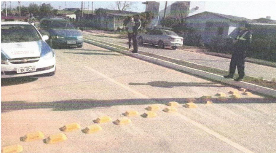
Foto 4 – Redutor tipo tachões instalado em Guaíba/RS
