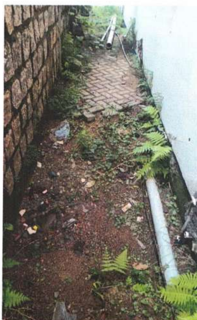
Limpeza, refazer o calçamento pavies, enterrar tubo esgoto
