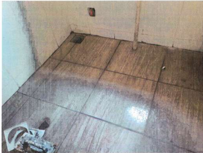
Remover e refazer rejunte dos revestimentos cerâmicos
