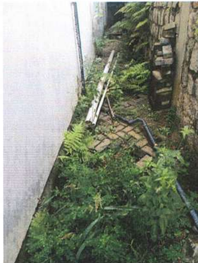
Limpeza, remover pavies e executar rede pluvial e refazer calçamento
