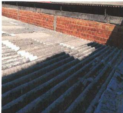
Salpicar e rebocar platibanda
