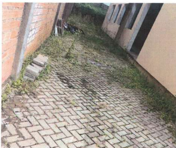
Remoção capim e sujeira calçamento
