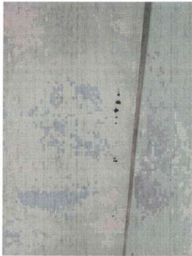
Forro gesso com orifícios
