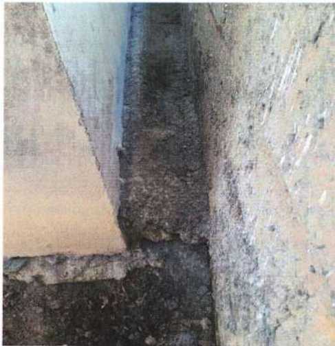
Dreno fundos do prédio coberto com massa
