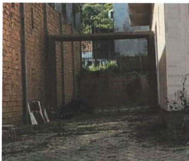
Remoção portão ferro
