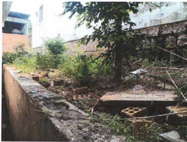
Colocar brita no canteiro muro contenção
