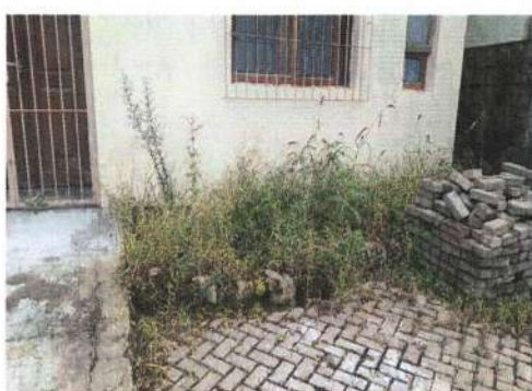
Remover floreiras e colocar piso blocos intertravado
