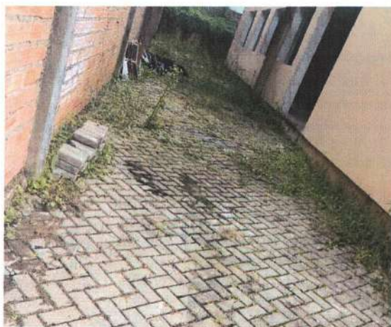
Remoção capim e sujeira calçamento
