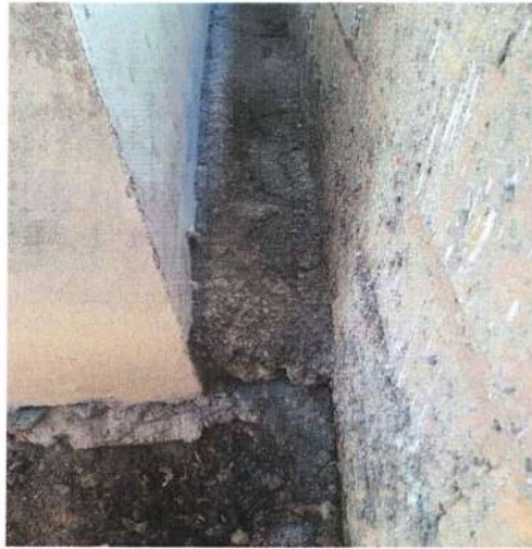
Dreno fundos do prédio coberto com massa
