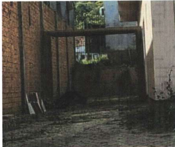
Remoção portão ferro
