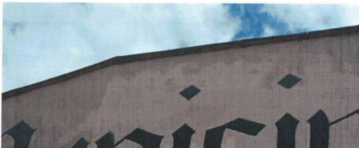
Remoção cerâmica na platibanda
