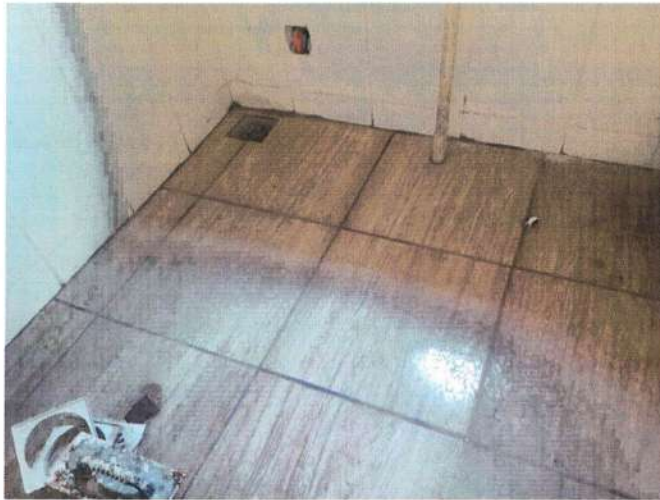
Remover e refazer rejunte dos revestimentos cerâmicos
