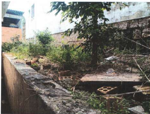
Colocar brita no canteiro muro contenção
