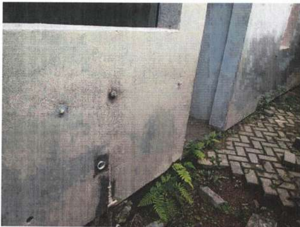
As instalações do tanque serão remanejados para o outro lado da porta
