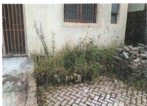
Remover floreiras e colocar piso blocos intertravado
