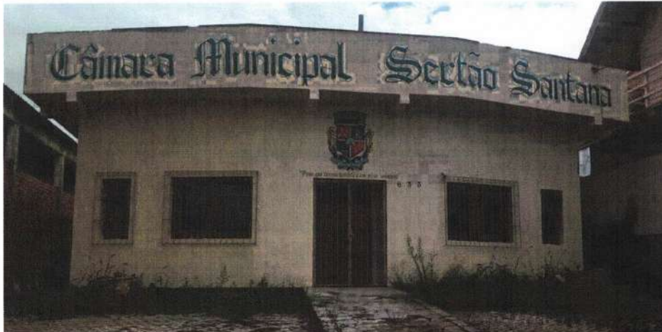
Remover todas esquadrias madeira e grades
