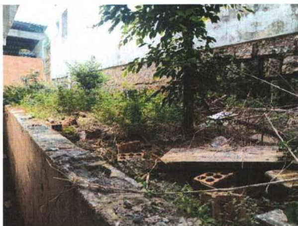
Colocar brita no canteiro muro contenção
