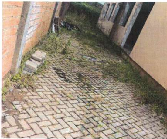
Remoção capim e sujeira calçamento
