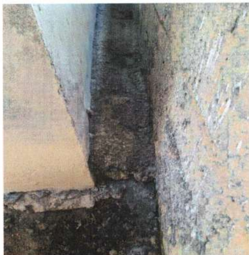
Dreno fundos do prédio coberto com massa
