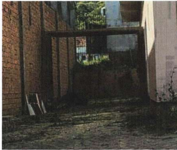
Remoção portão ferro
