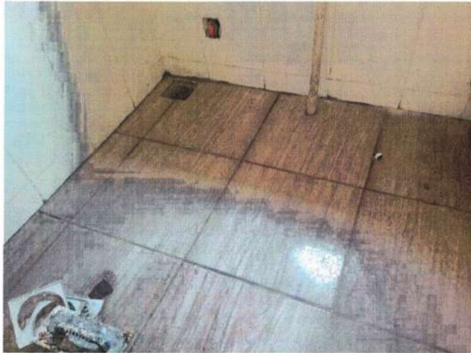
Remover e refazer rejunte dos revestimentos cerâmicos
