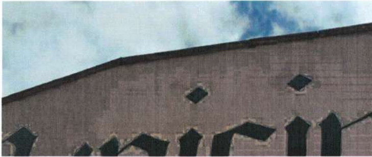
Remoção cerâmica na platibanda
