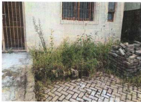
Remover floreiras e colocar piso blocos intertravado
