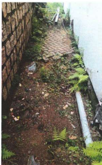
Limpeza, refazer o calçamento pavies, enterrar tubo esgoto
